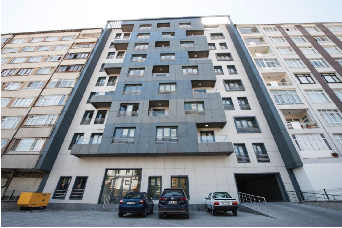
(Sosyal Tesis Binası)
